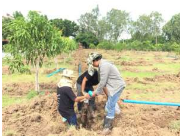
วางระบบท่อส่งน้ำ : ท่อเมน และ ท่อแขนง
